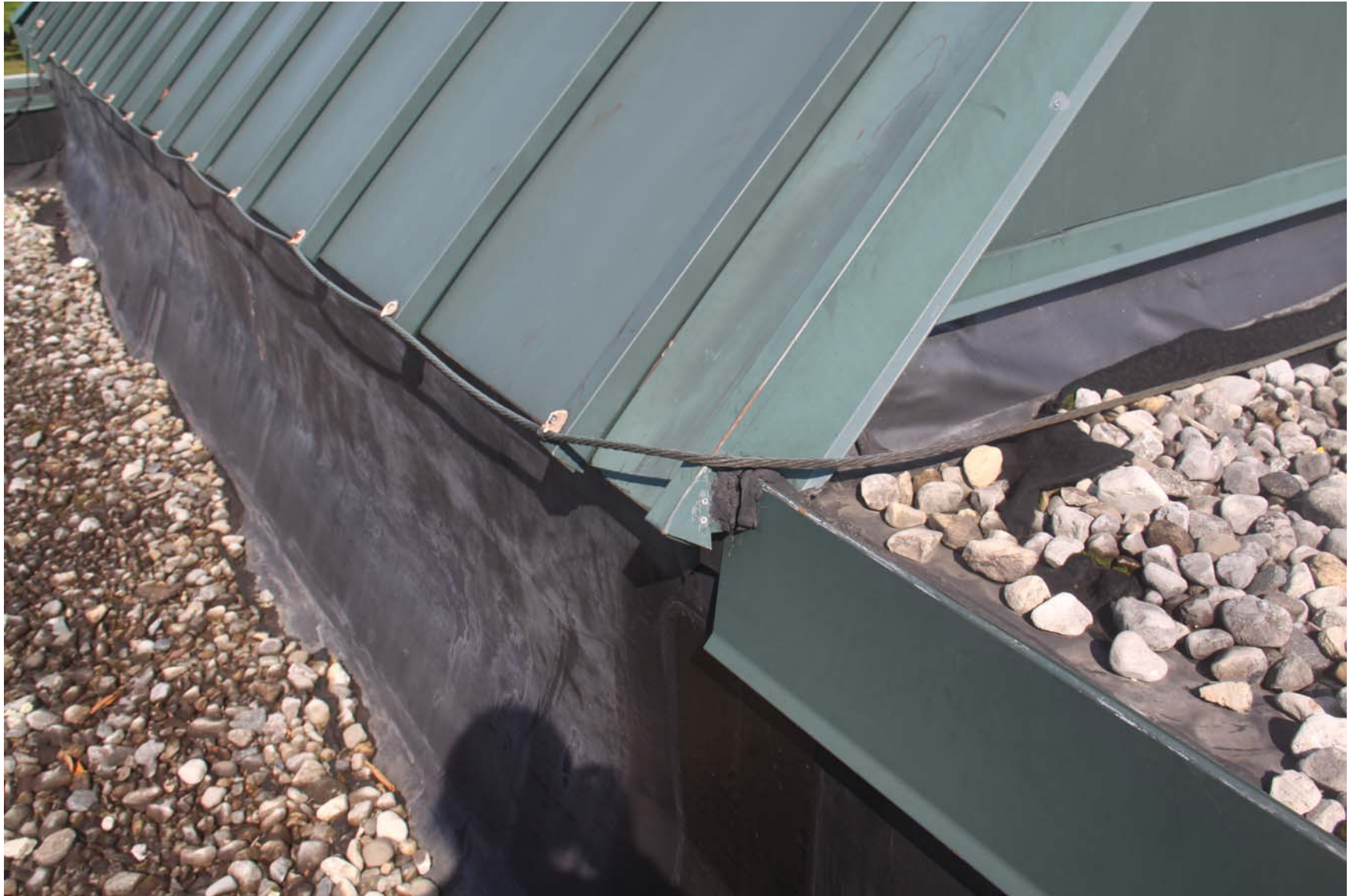
2219-00_19_0801 - ECs Roof [MP] (1083).JPG
