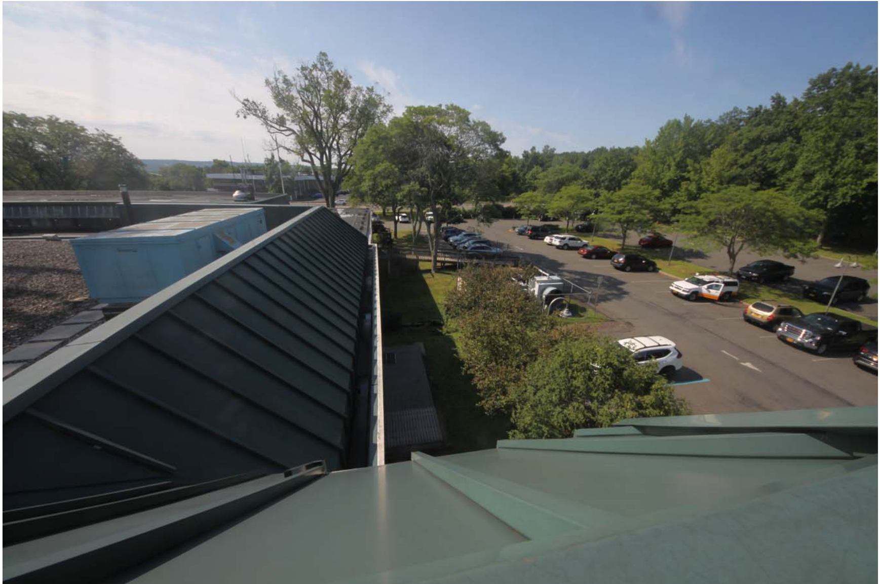
2219-00_19_0801 - ECs Roof [MP] (1159).JPG
