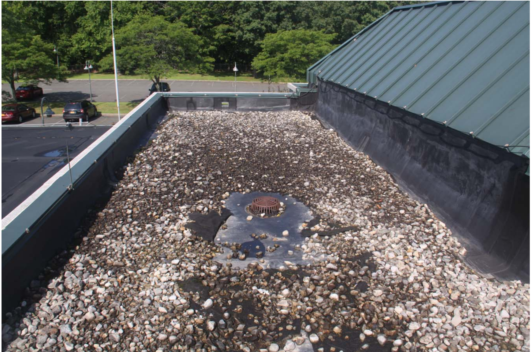
2219-00_19_0801 - ECs Roof [MP] (1053).JPG
