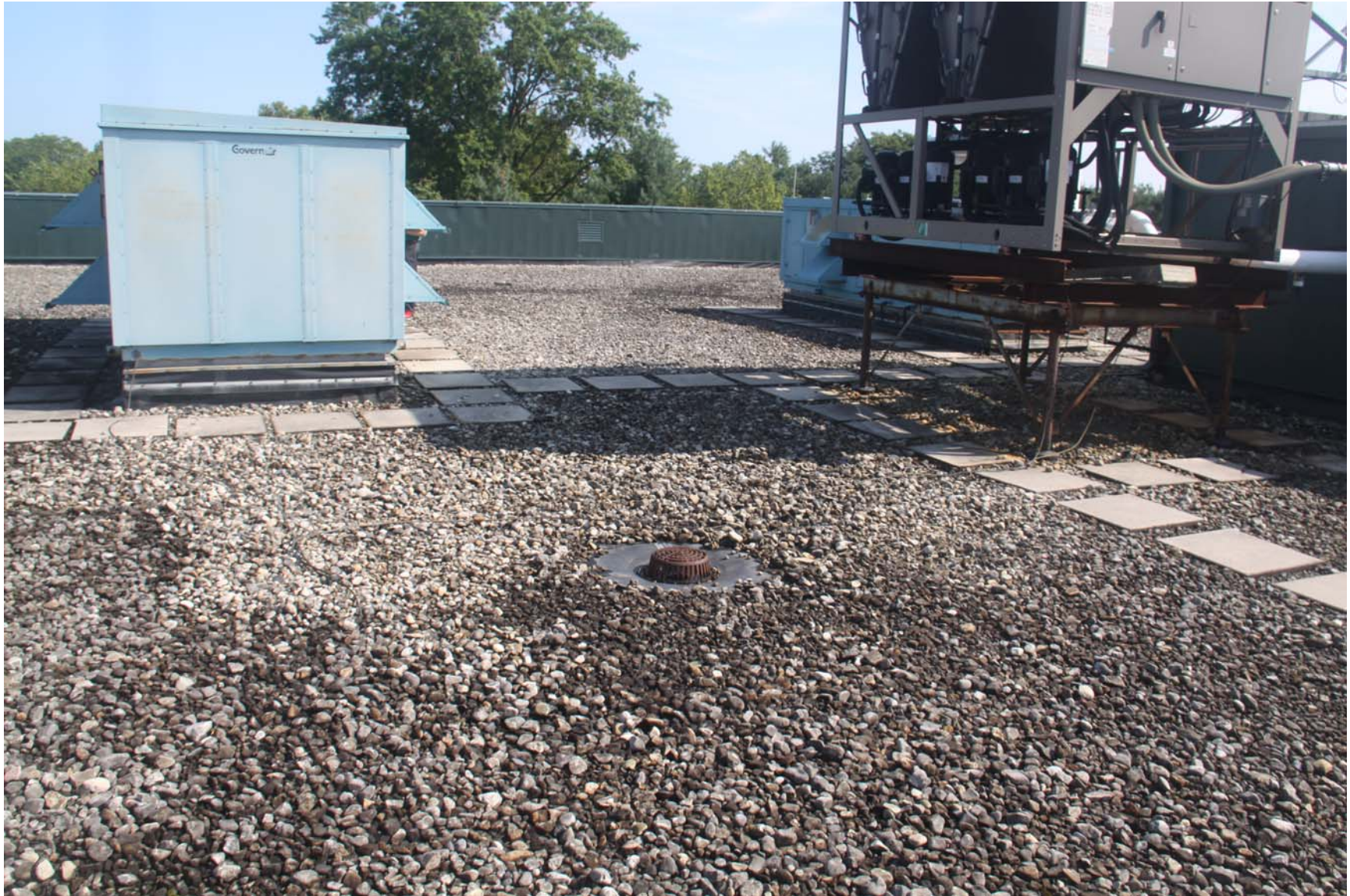
2219-00_19_0801 - ECs Roof [MP] (1108).JPG
