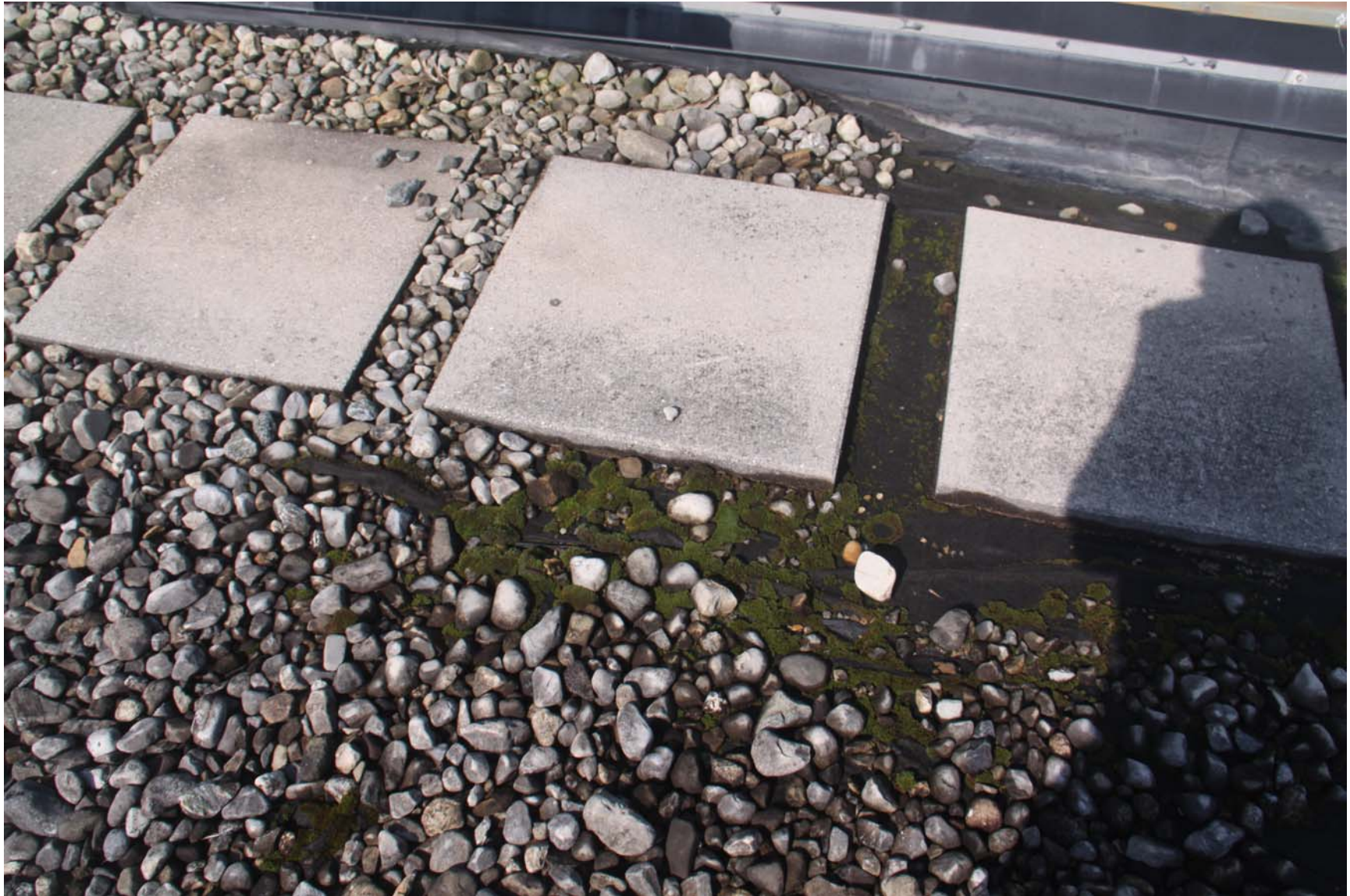
2219-00_19_0801 - ECs Roof [MP] (1015).JPG
