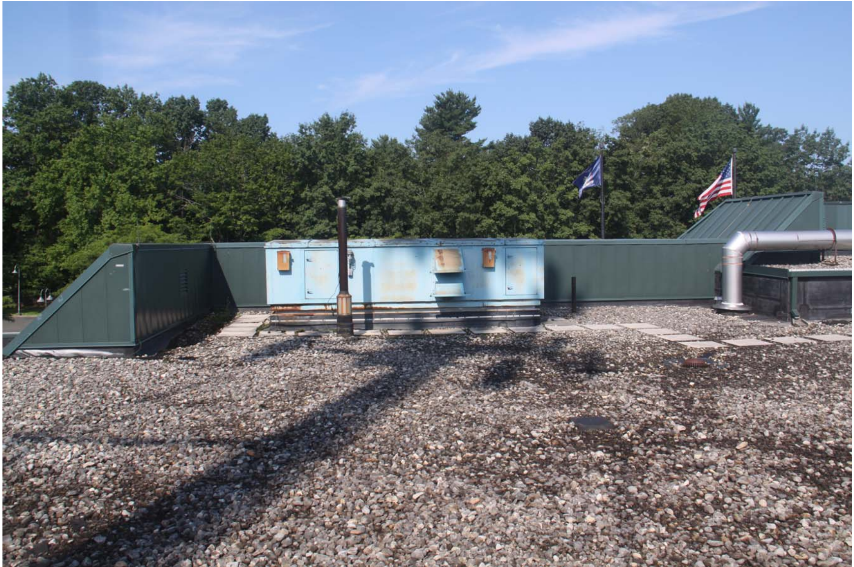
2219-00_19_0801 - ECs Roof [MP] (1041).JPG
