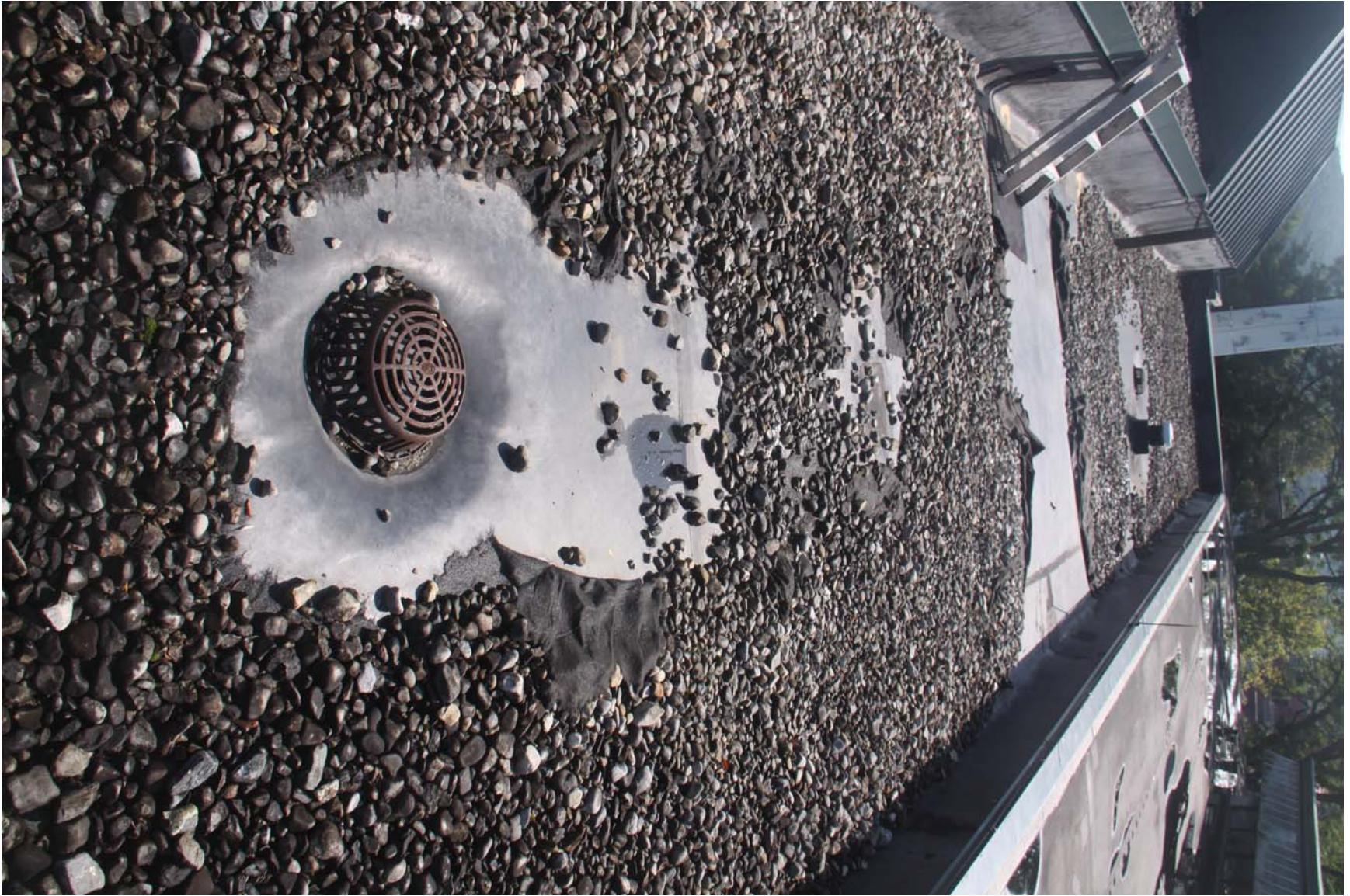
2219-00_19_0801 - ECs Roof [MP] (1065).JPG
