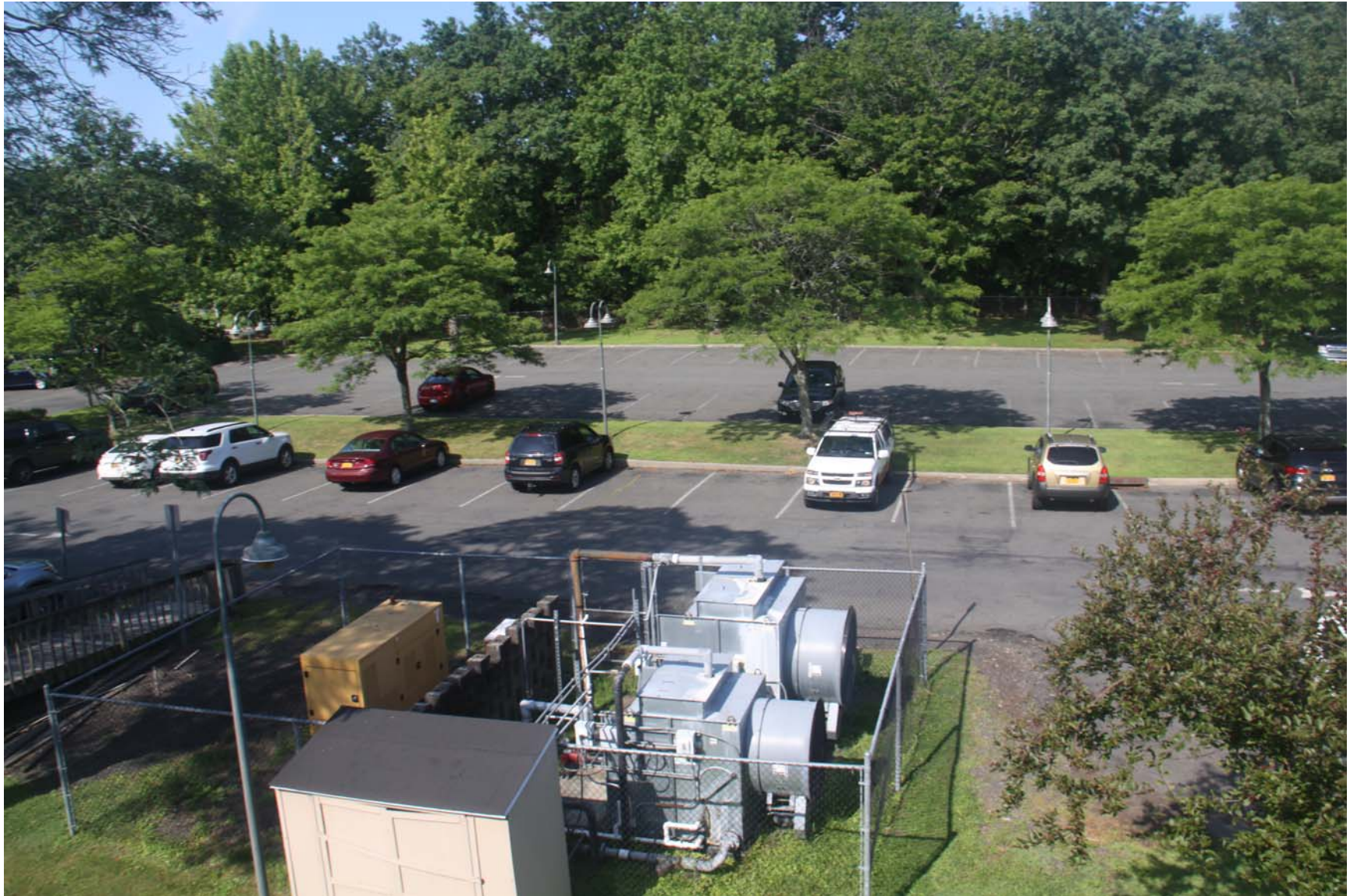
2219-00_19_0801 - ECs Roof [MP] (1057).JPG
