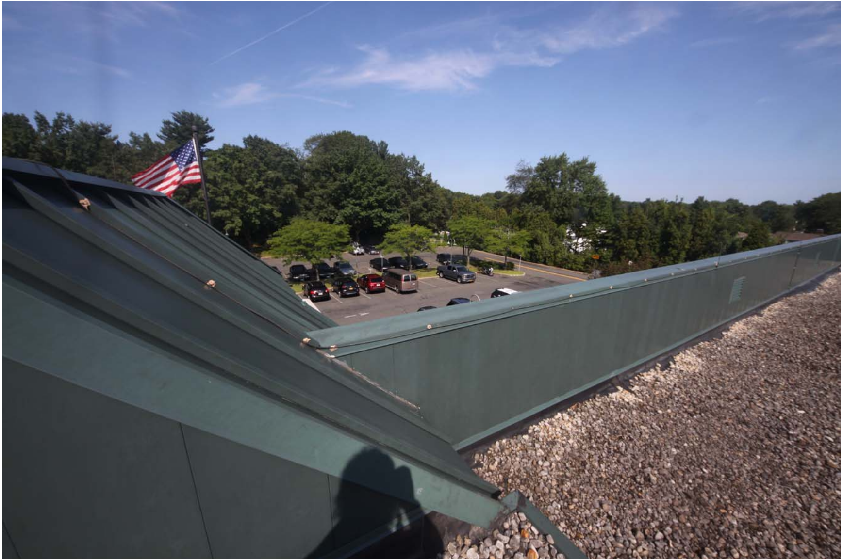
2219-00_19_0801 - ECs Roof [MP] (1154).JPG
