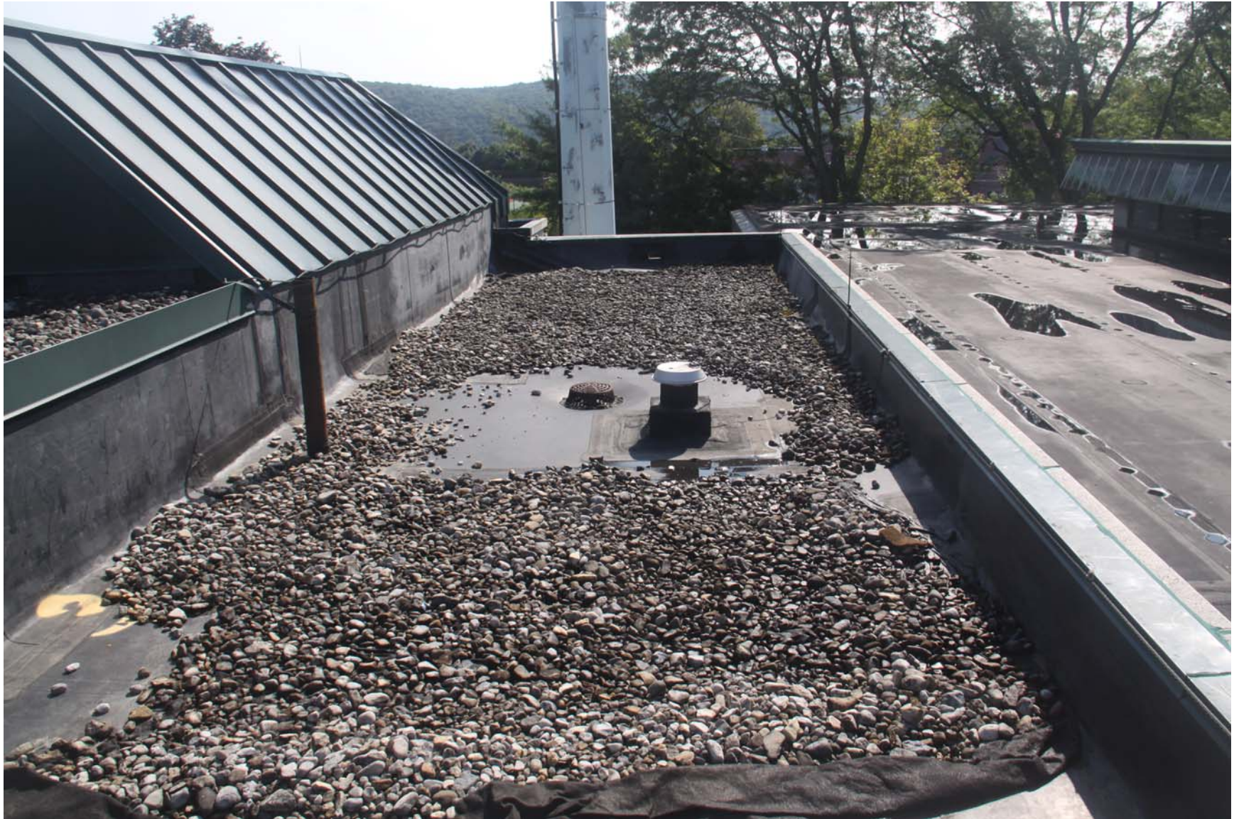
2219-00_19_0801 - ECs Roof [MP] (1051).JPG
