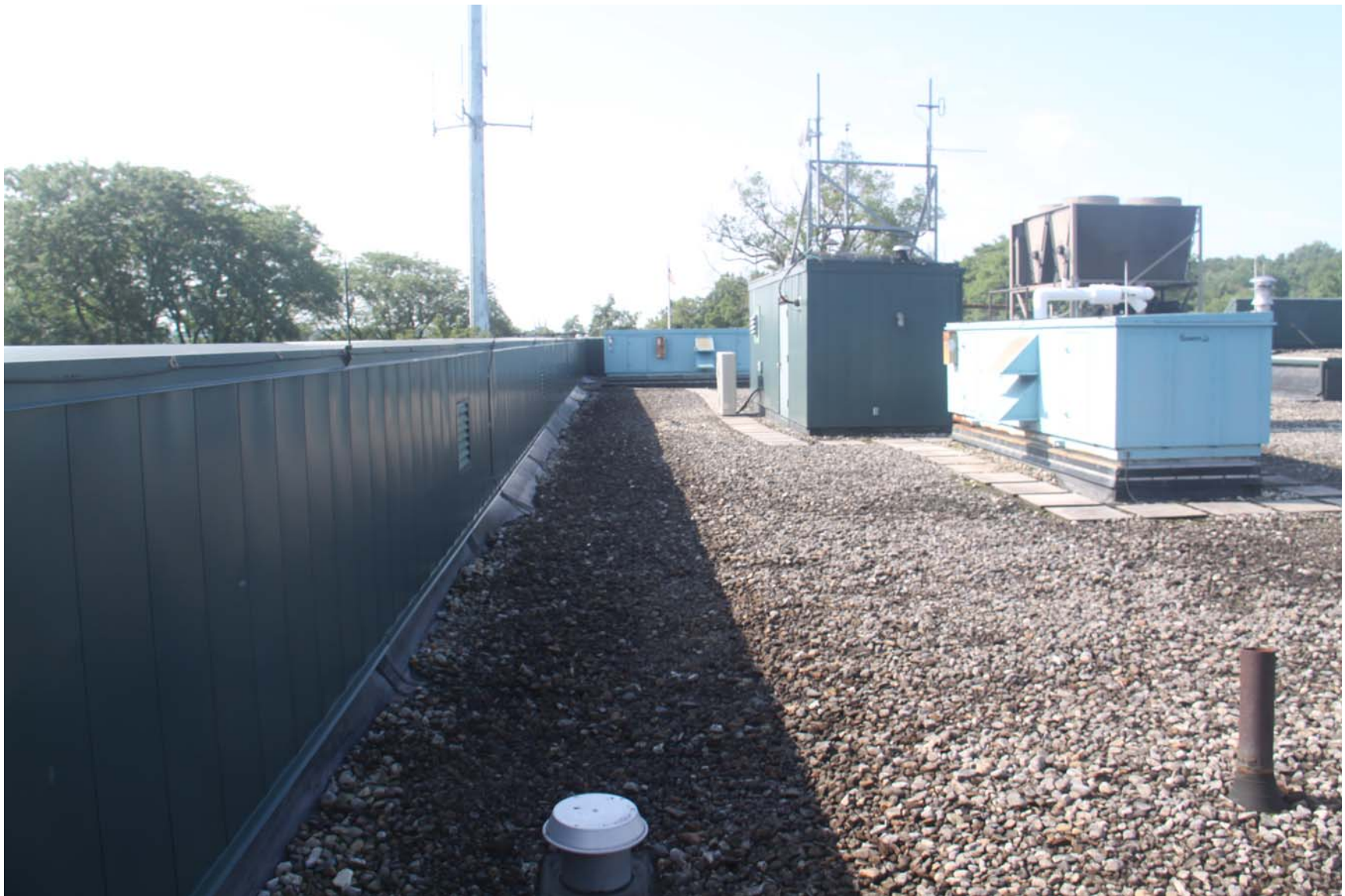
2219-00_19_0801 - ECs Roof [MP] (1005).JPG
