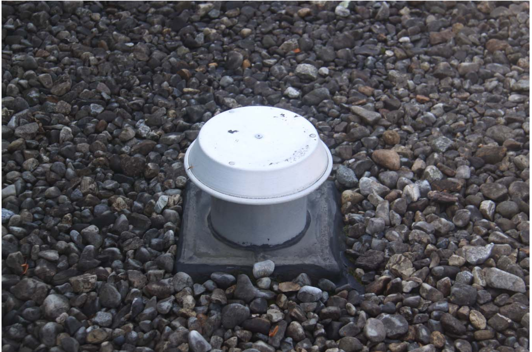
2219-00_19_0801 - ECs Roof [MP] (1007).JPG
