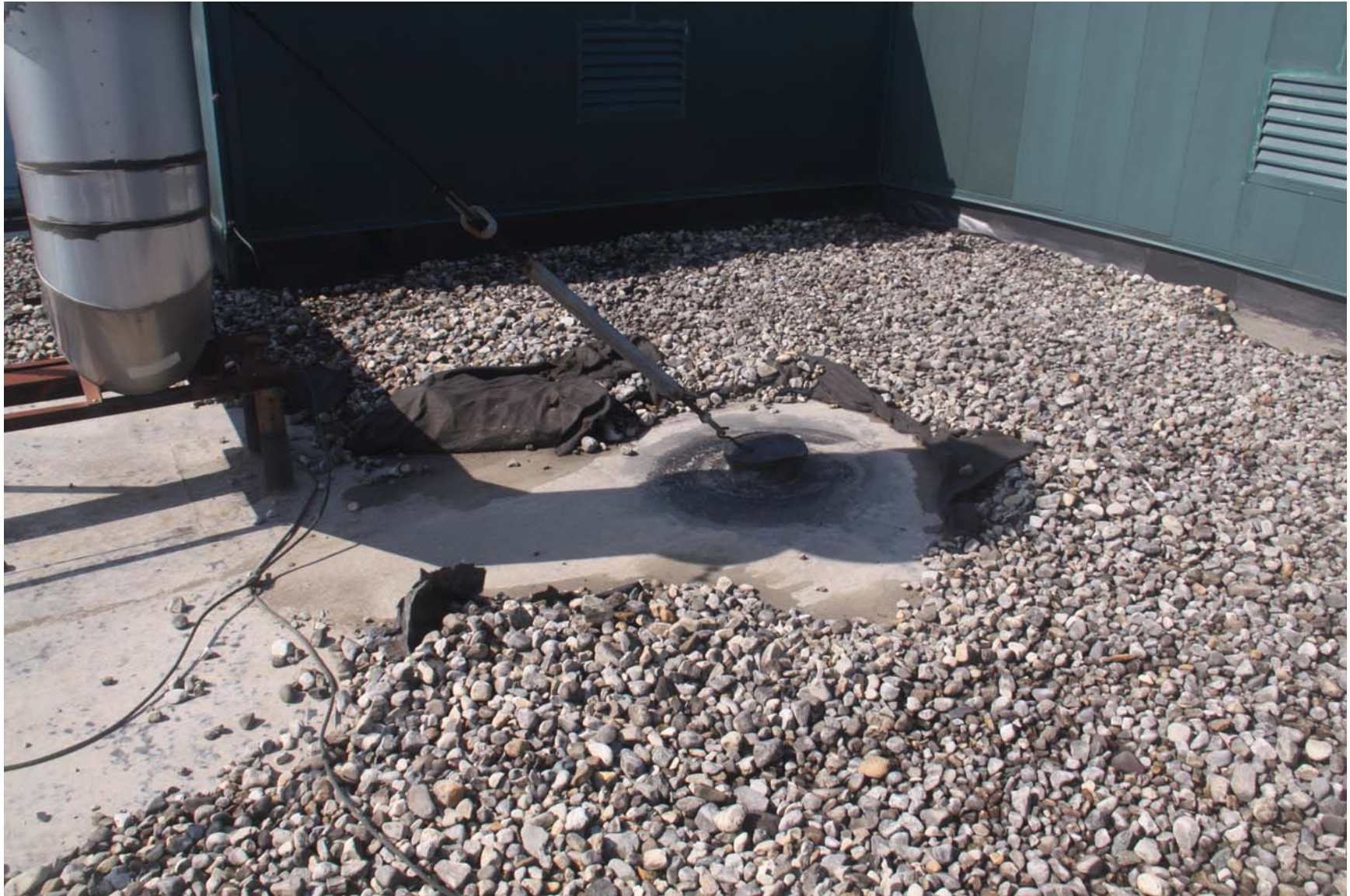
2219-00_19_0801 - ECs Roof [MP] (1133).JPG
