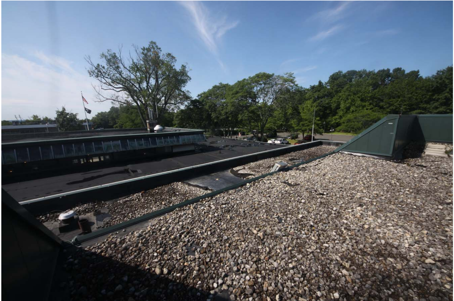
2219-00_19_0801 - ECs Roof [MP] (1175).JPG
