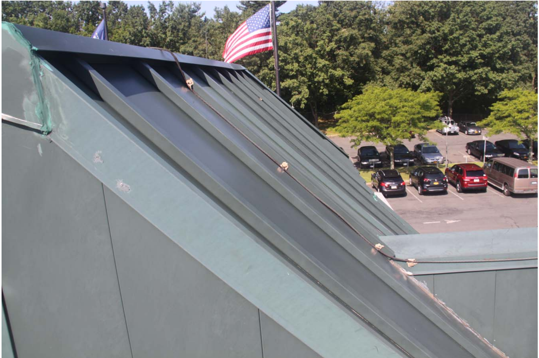
2219-00_19_0801 - ECs Roof [MP] (1143).JPG
