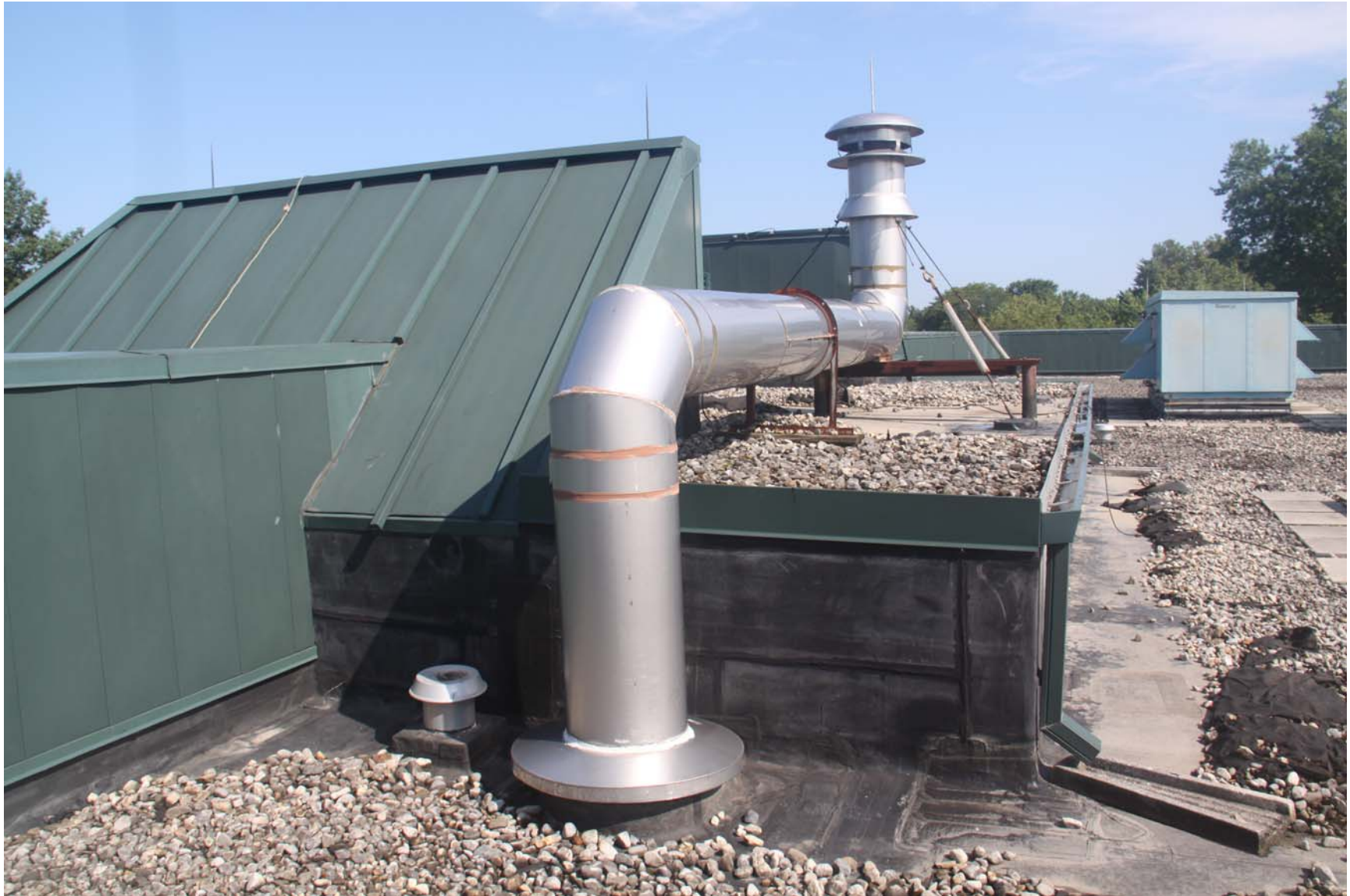
2219-00_19_0801 - ECs Roof [MP] (1094).JPG
