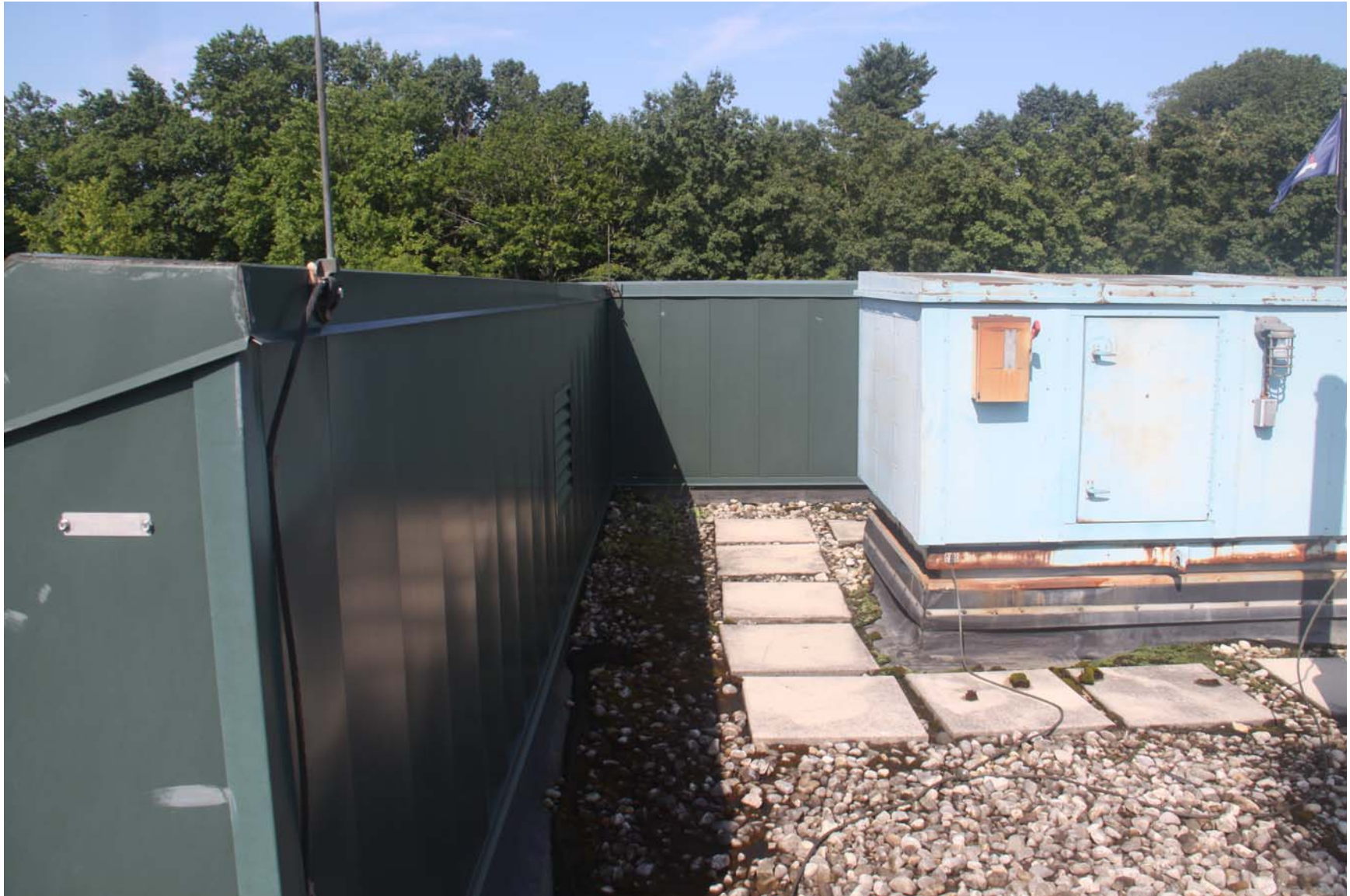
2219-00_19_0801 - ECs Roof [MP] (1084).JPG
