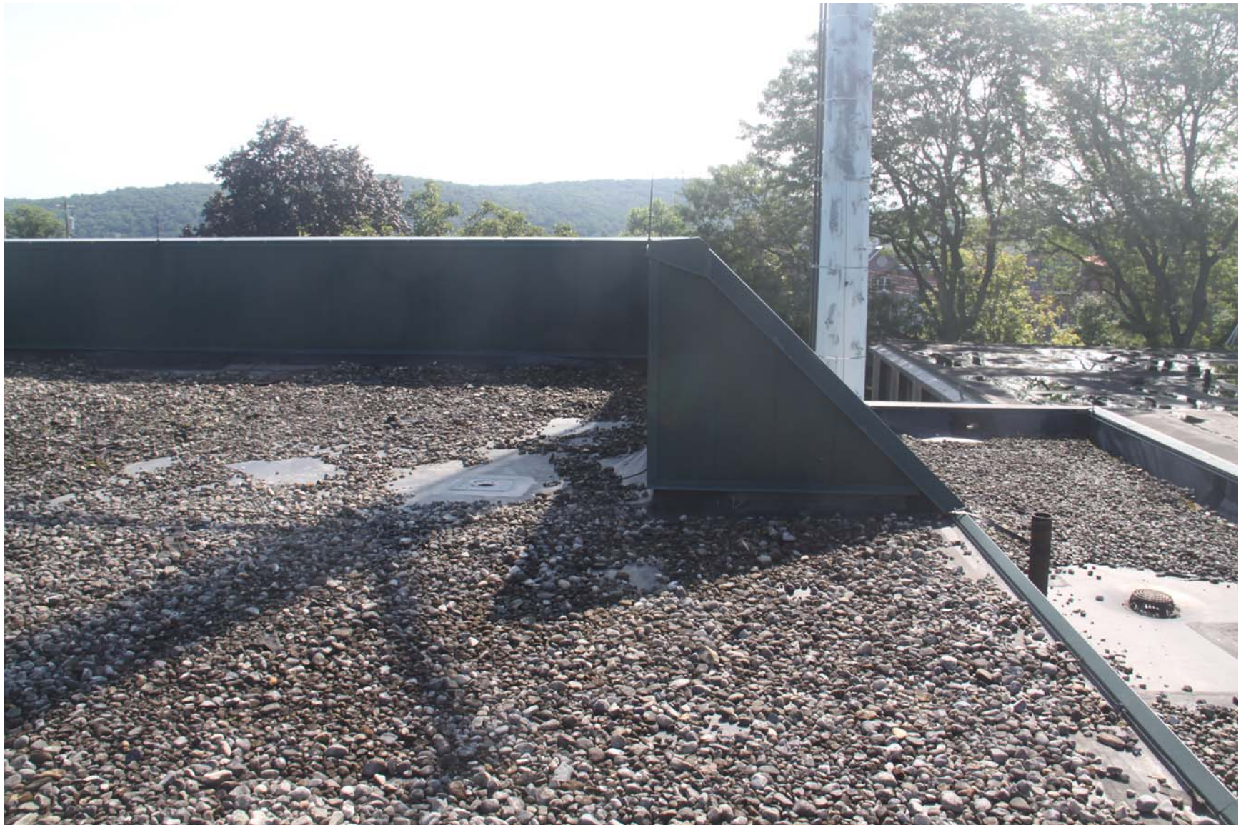
2219-00_19_0801 - ECs Roof [MP] (1050).JPG
