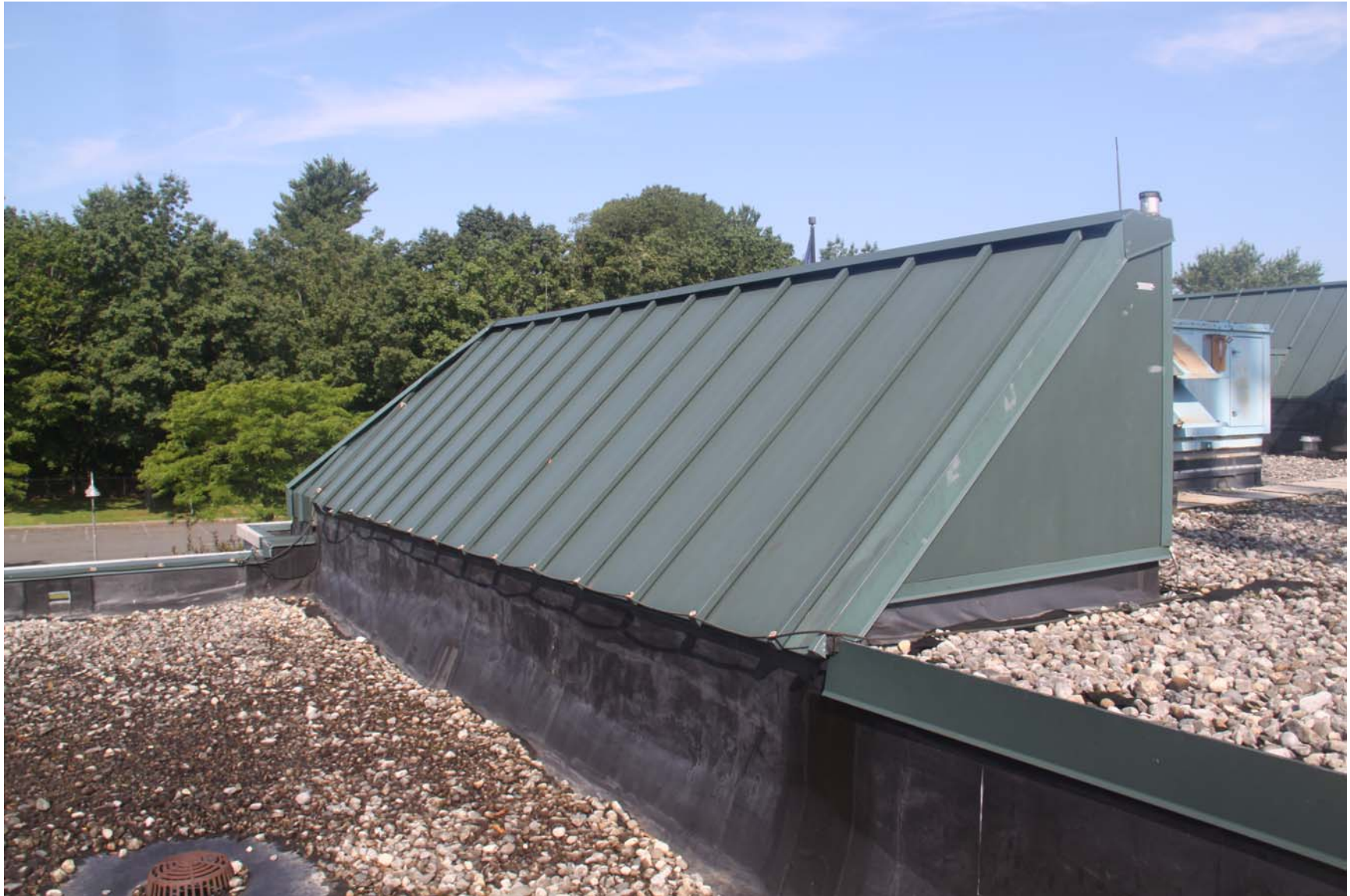
2219-00_19_0801 - ECs Roof [MP] (1054).JPG
