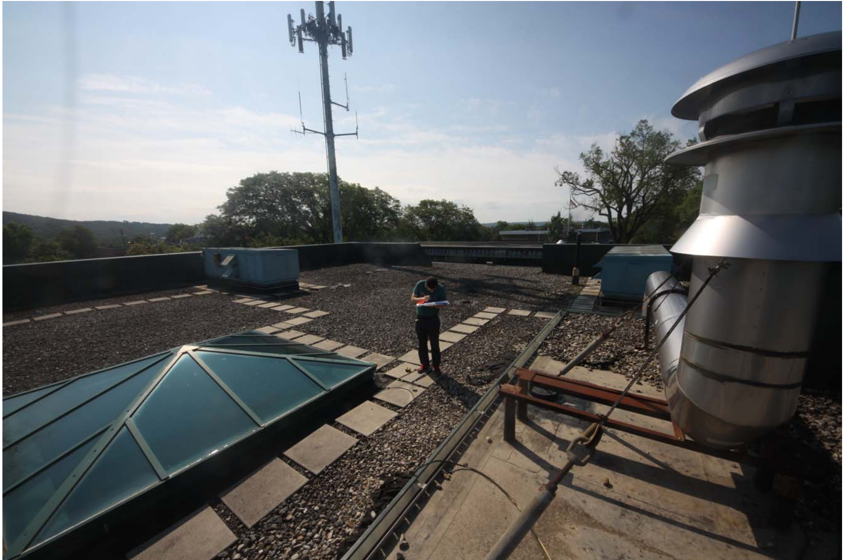
2219-00_19_0801 - ECs Roof [MP] (1162).JPG
