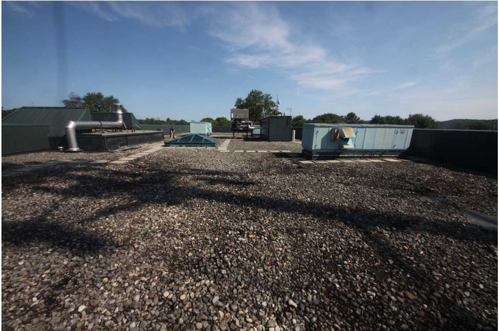
2219-00_19_0801 - ECs Roof [MP] (1176).JPG
