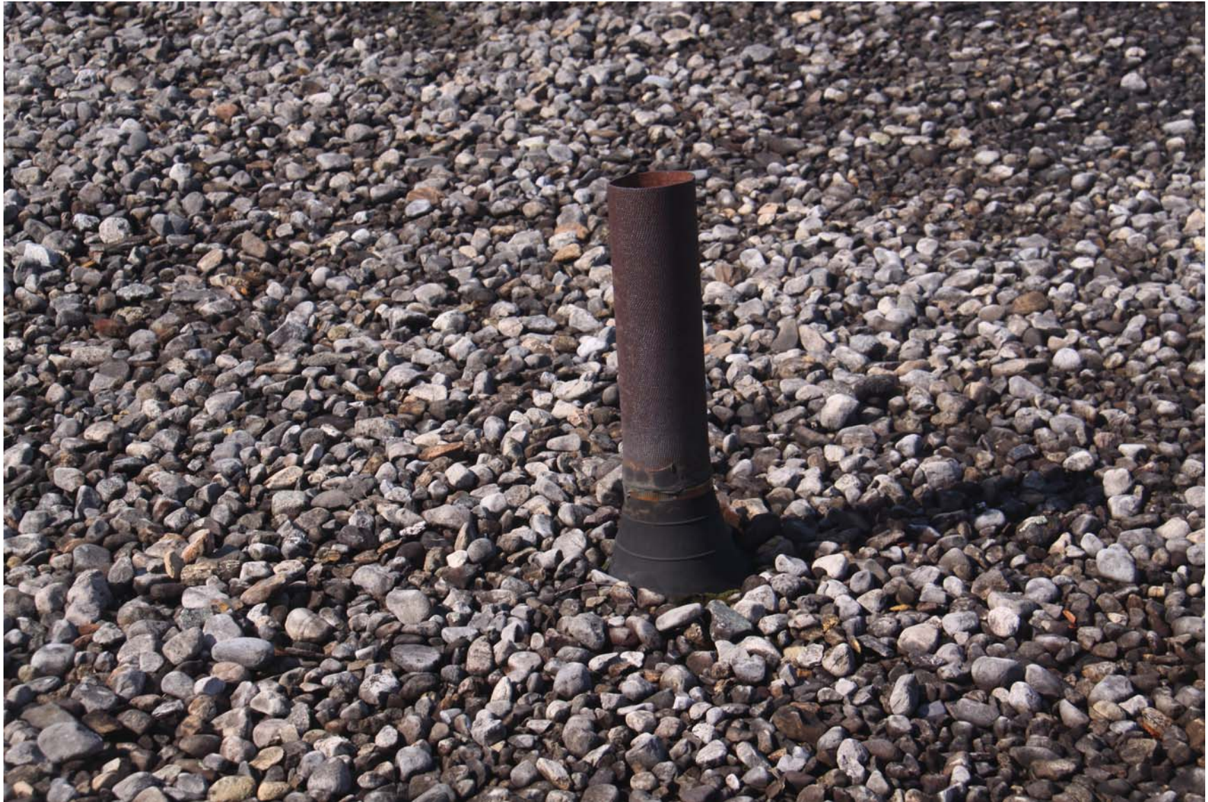
2219-00_19_0801 - ECs Roof [MP] (1008).JPG
