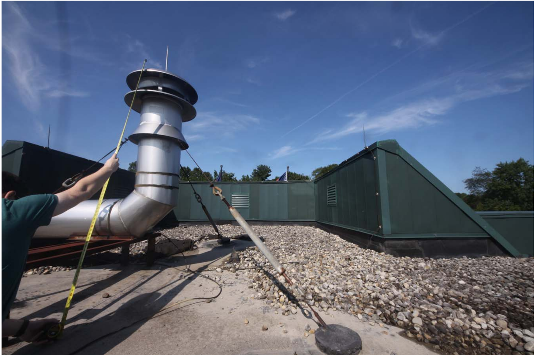
2219-00_19_0801 - ECs Roof [MP] (1165).JPG
