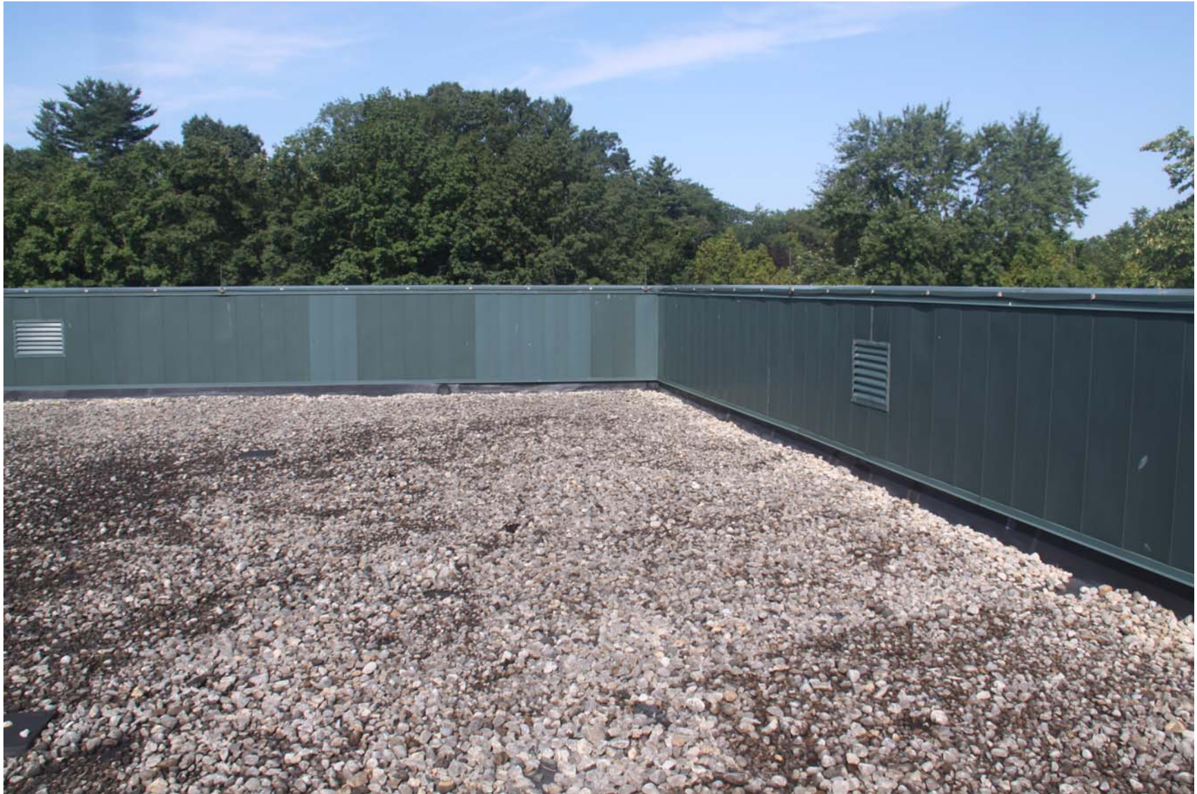
2219-00_19_0801 - ECs Roof [MP] (1004).JPG
