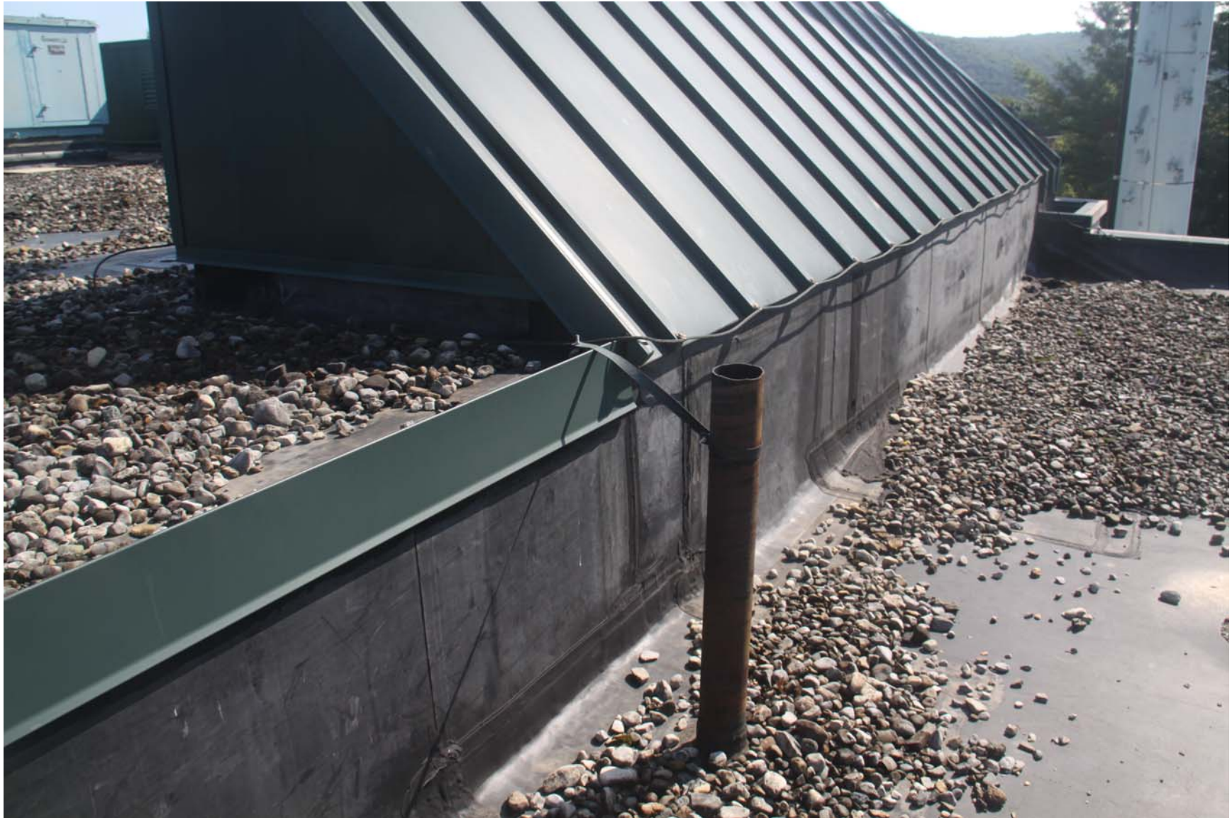
2219-00_19_0801 - ECs Roof [MP] (1082).JPG
