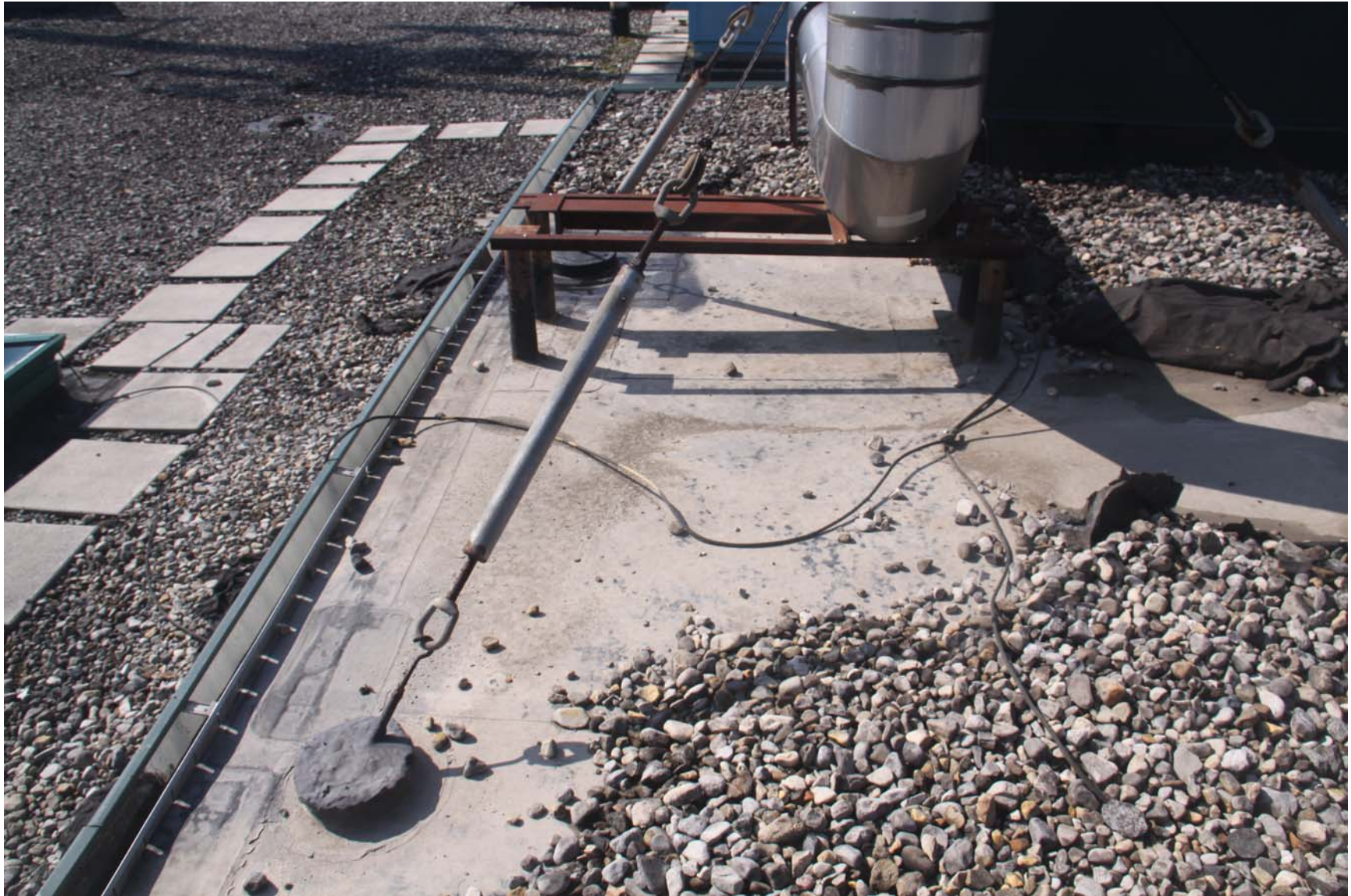
2219-00_19_0801 - ECs Roof [MP] (1132).JPG
