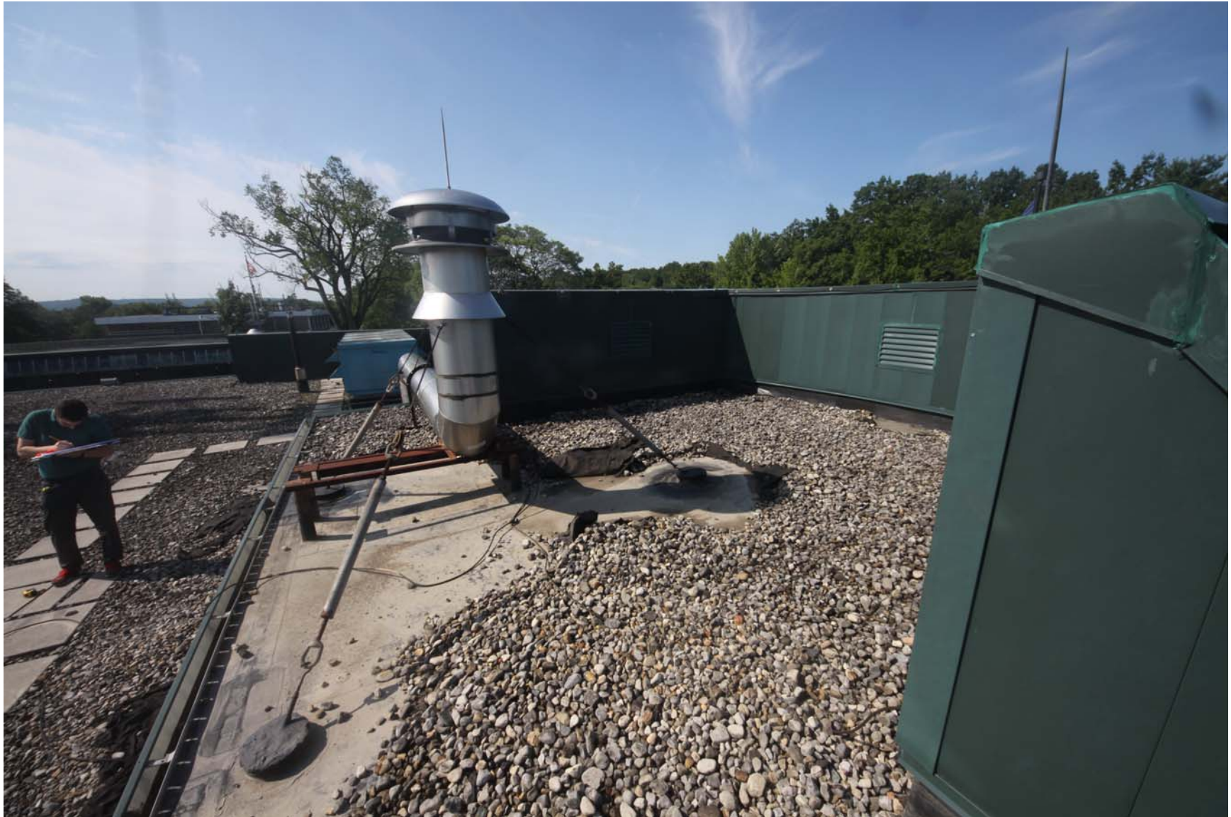
2219-00_19_0801 - ECs Roof [MP] (1153).JPG
