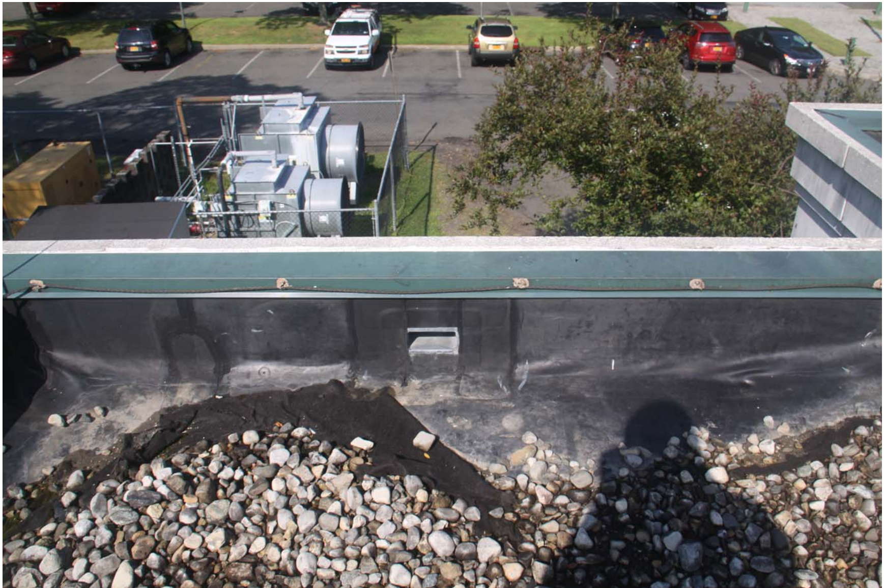
2219-00_19_0801 - ECs Roof [MP] (1055).JPG
