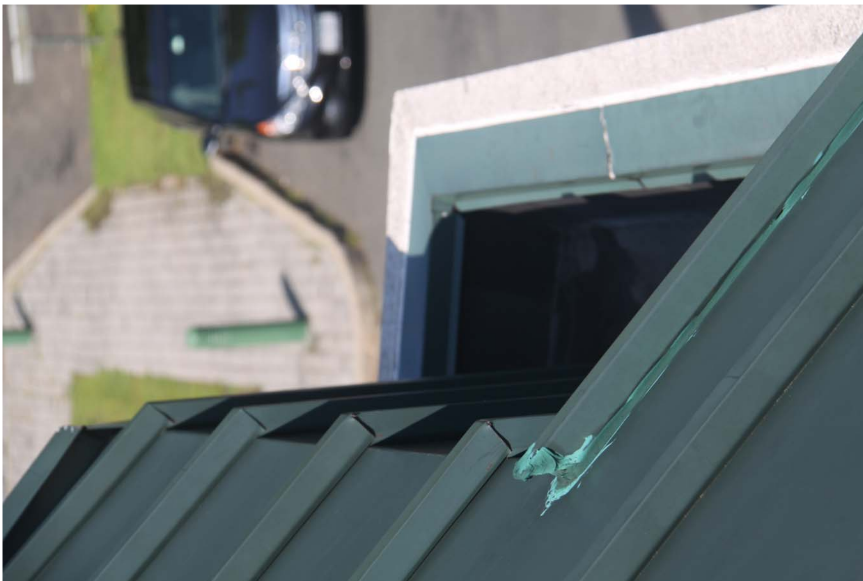
2219-00_19_0801 - ECs Roof [MP] (1183).JPG
