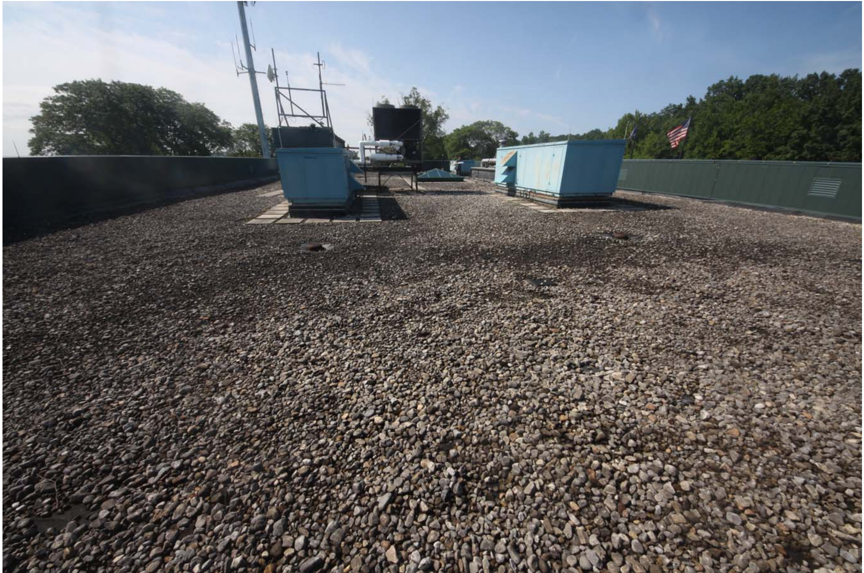
2219-00_19_0801 - ECs Roof [MP] (1172).JPG
