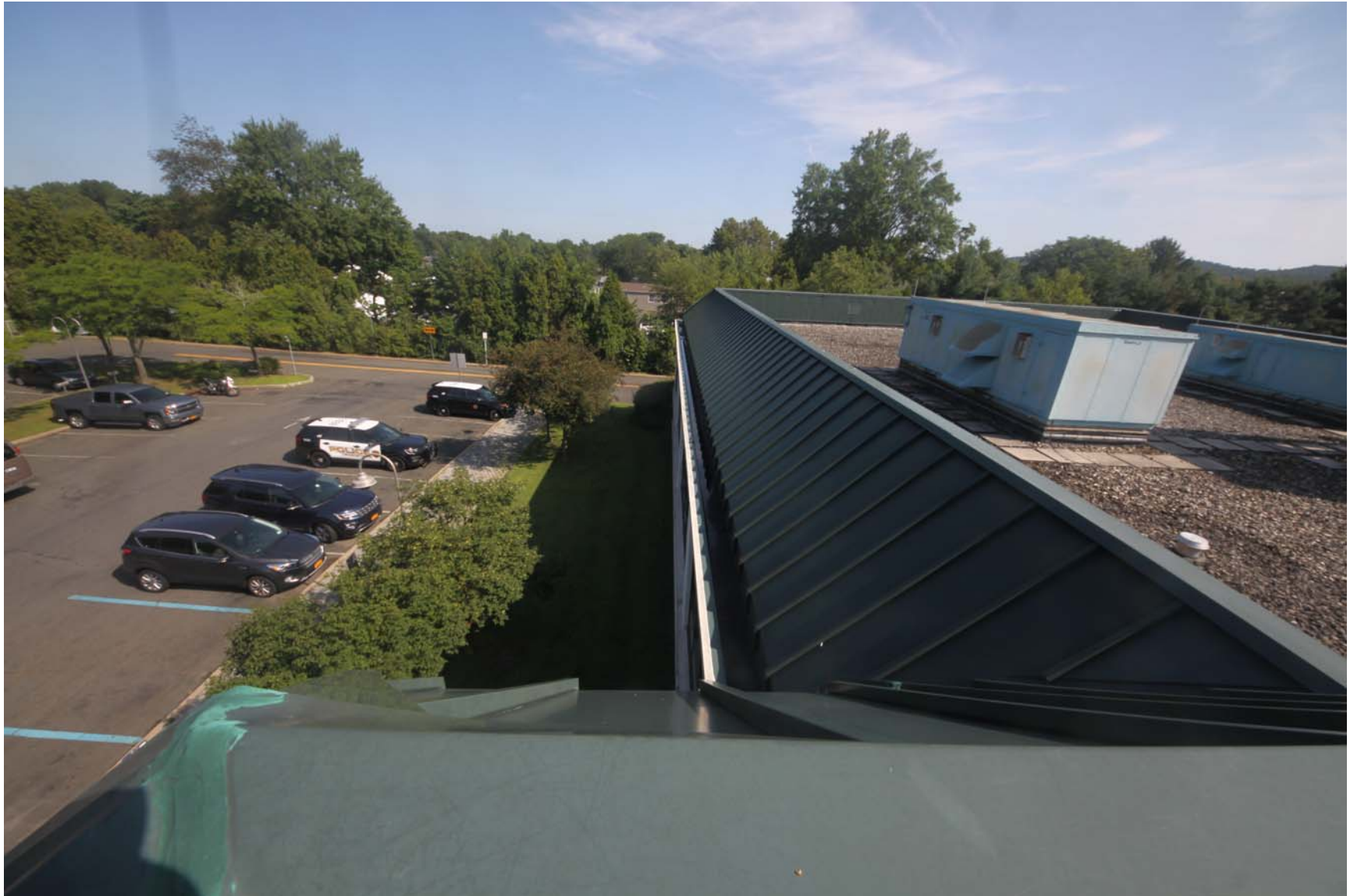
2219-00_19_0801 - ECs Roof [MP] (1158).JPG
