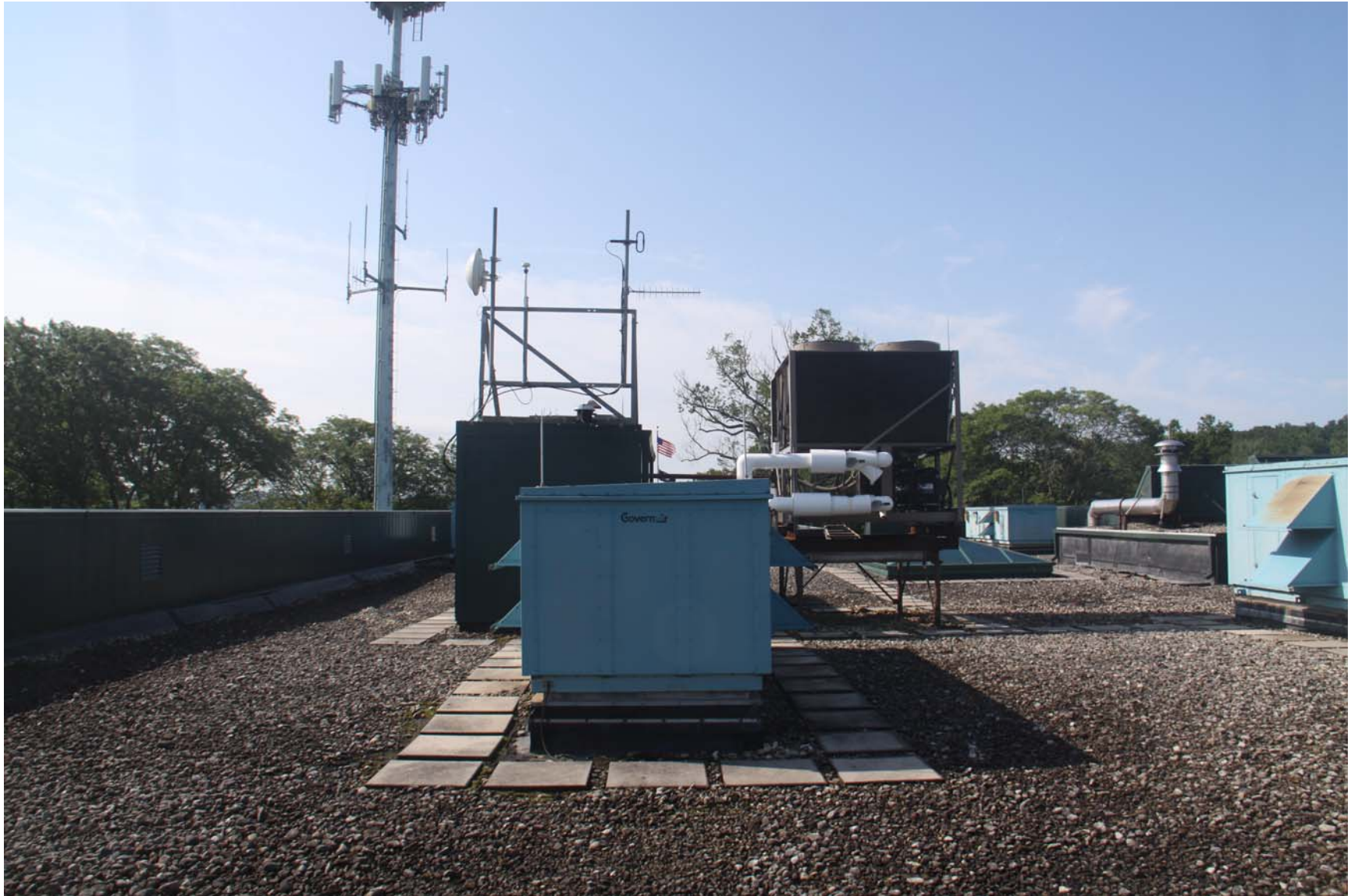
2219-00_19_0801 - ECs Roof [MP] (1003).JPG
