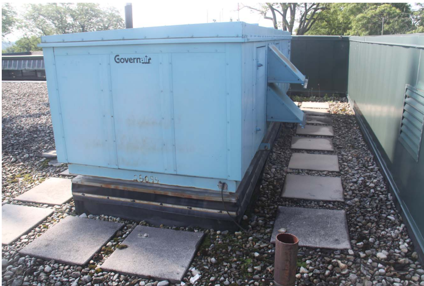
2219-00_19_0801 - ECs Roof [MP] (1093).JPG
