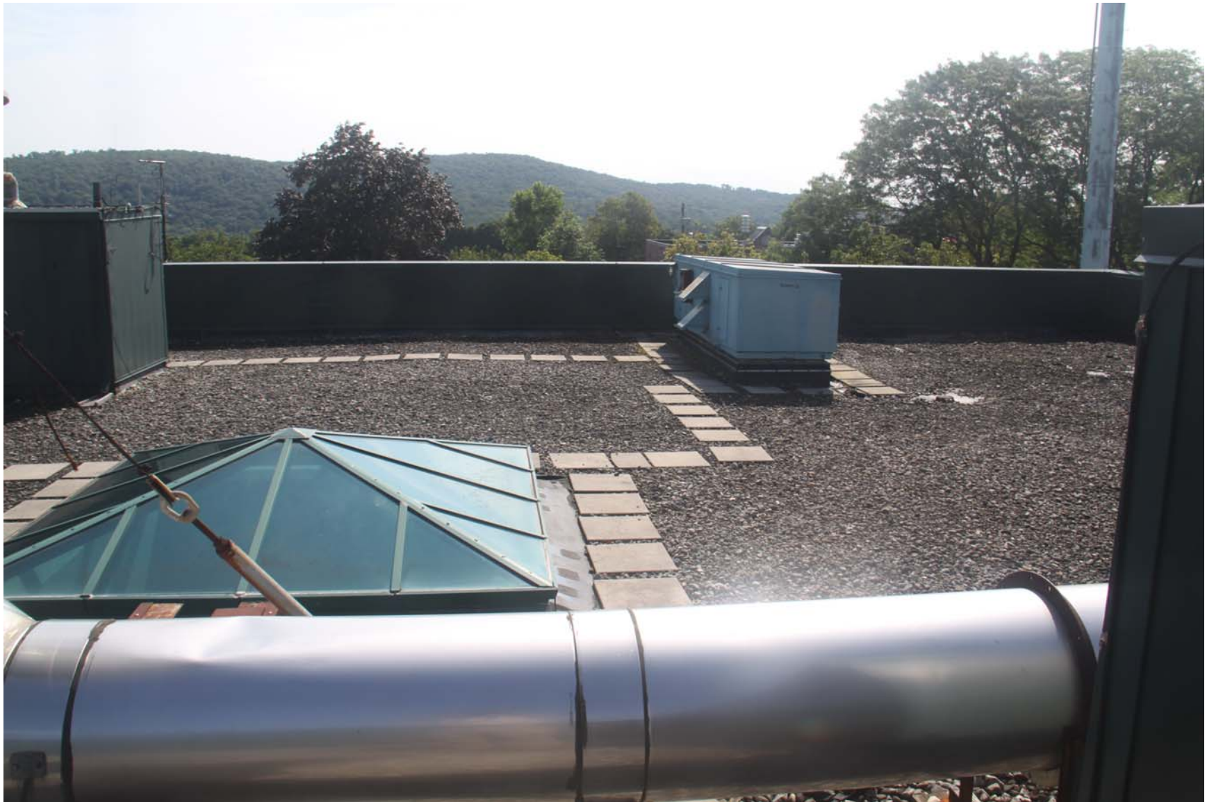
2219-00_19_0801 - ECs Roof [MP] (1138).JPG
