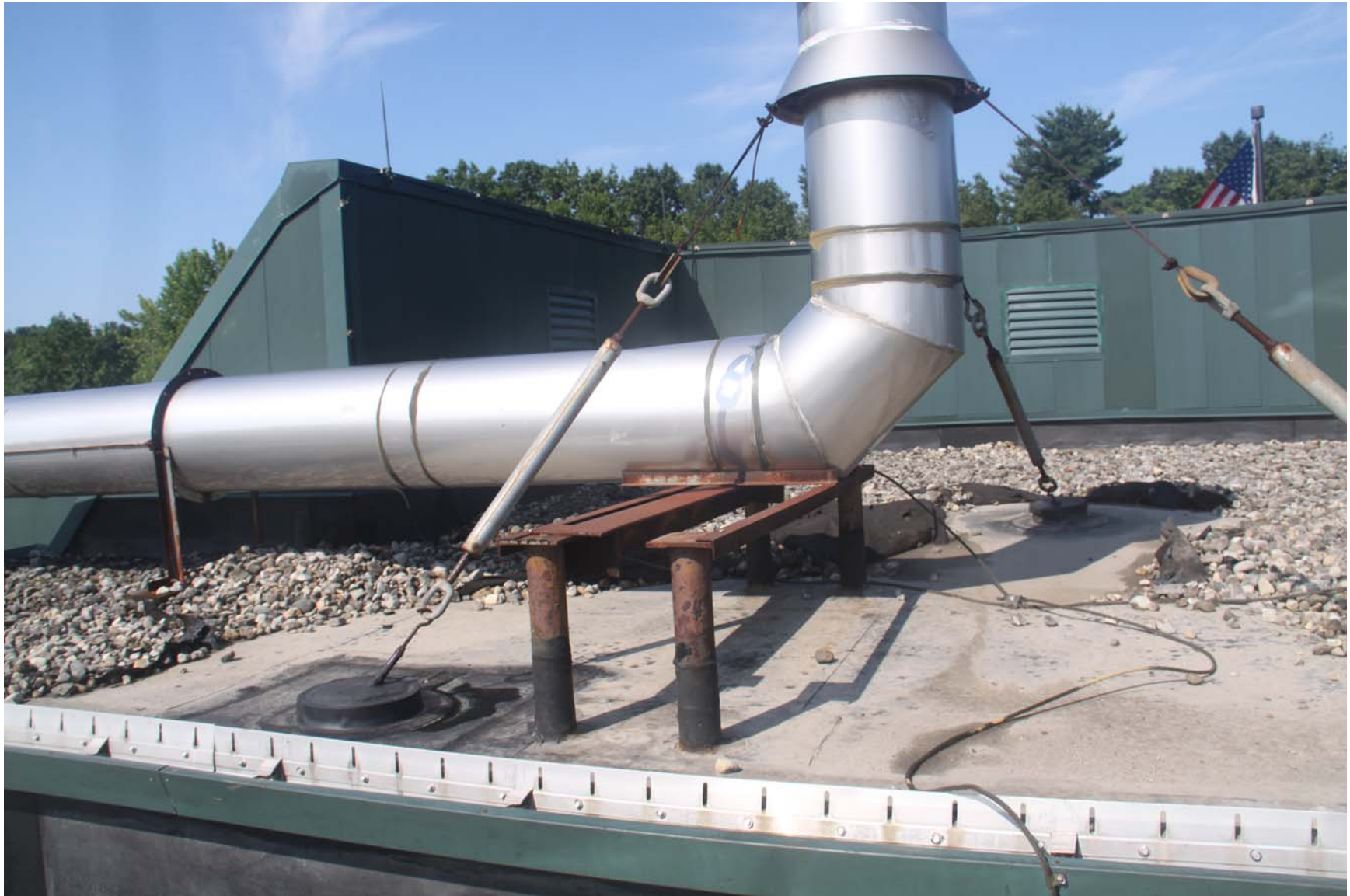
2219-00_19_0801 - ECs Roof [MP] (1104).JPG
