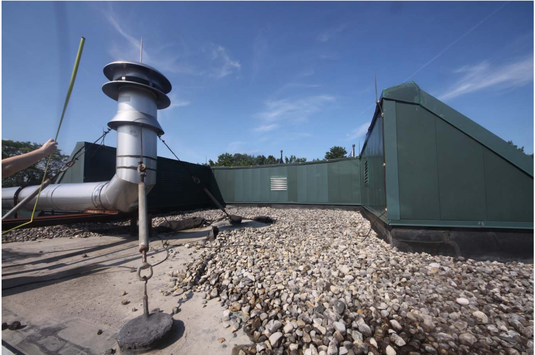
2219-00_19_0801 - ECs Roof [MP] (1164).JPG
