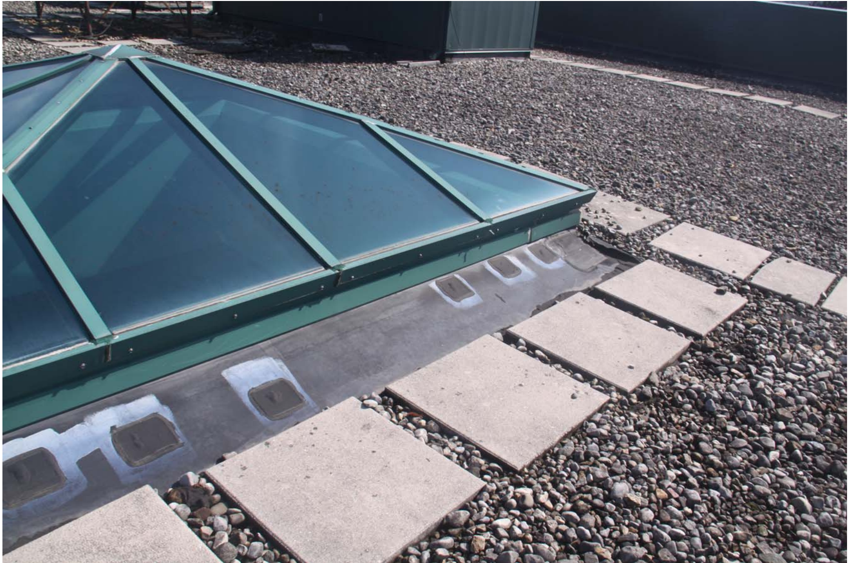
2219-00_19_0801 - ECs Roof [MP] (1102).JPG
