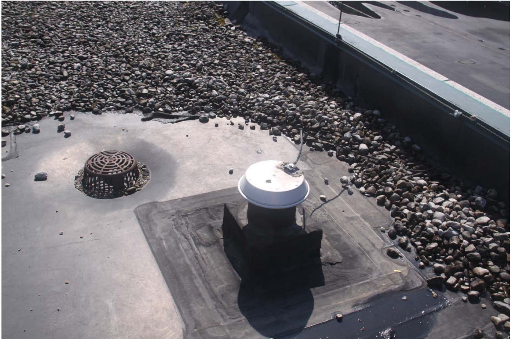
2219-00_19_0801 - ECs Roof [MP] (1073).JPG
