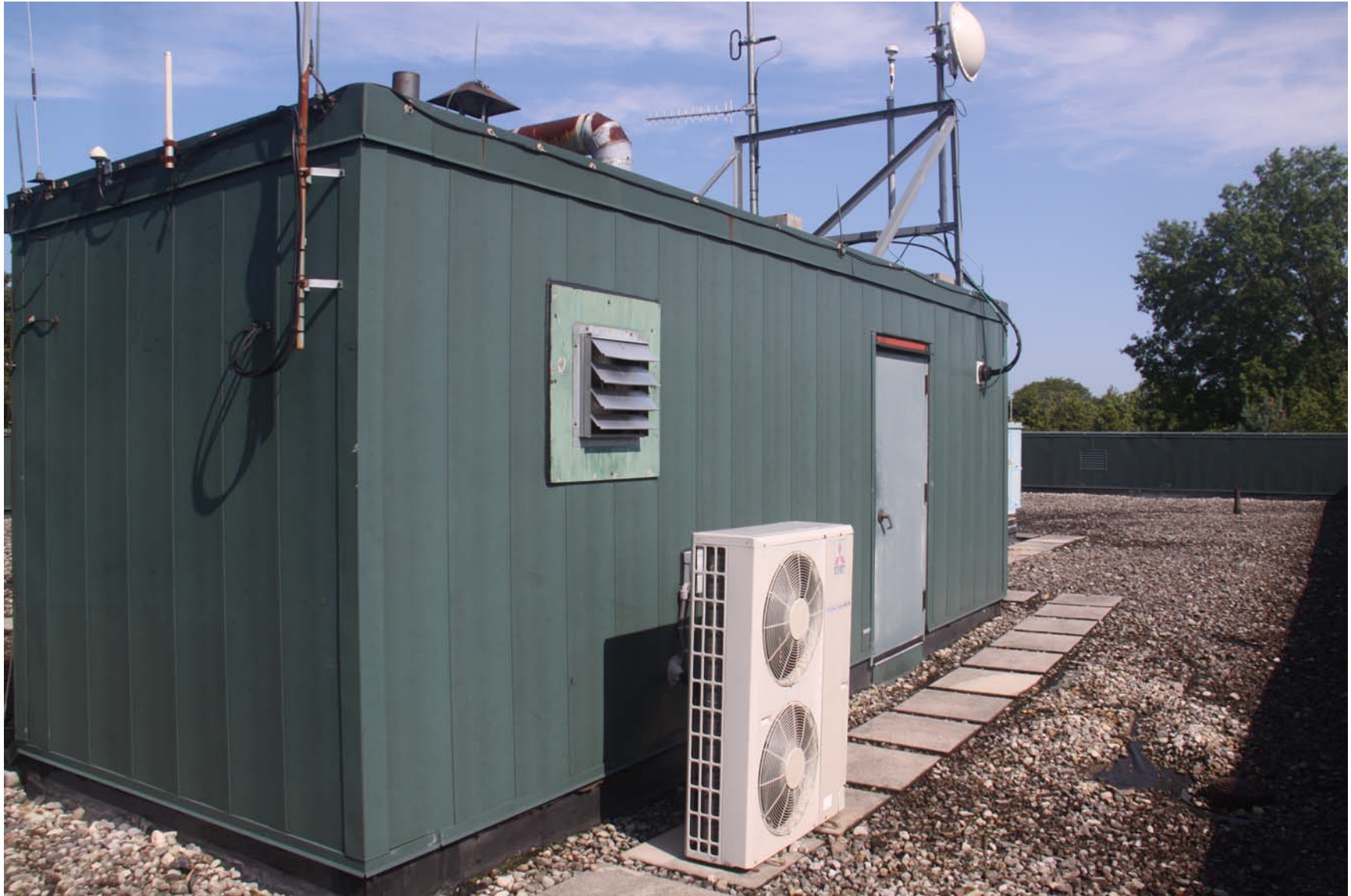
2219-00_19_0801 - ECs Roof [MP] (1024).JPG
