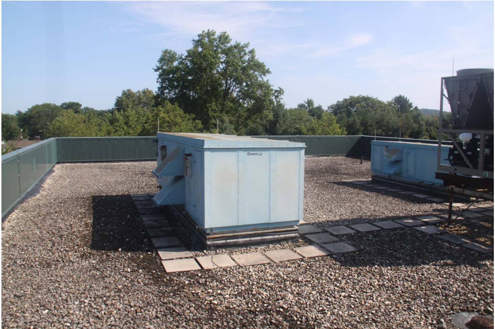
2219-00_19_0801 - ECs Roof [MP] (1145).JPG
