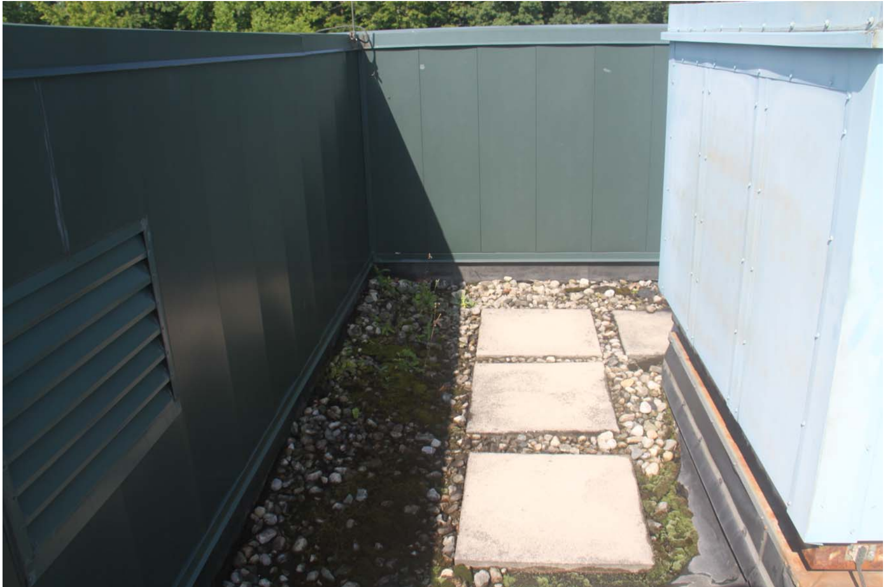
2219-00_19_0801 - ECs Roof [MP] (1087).JPG
