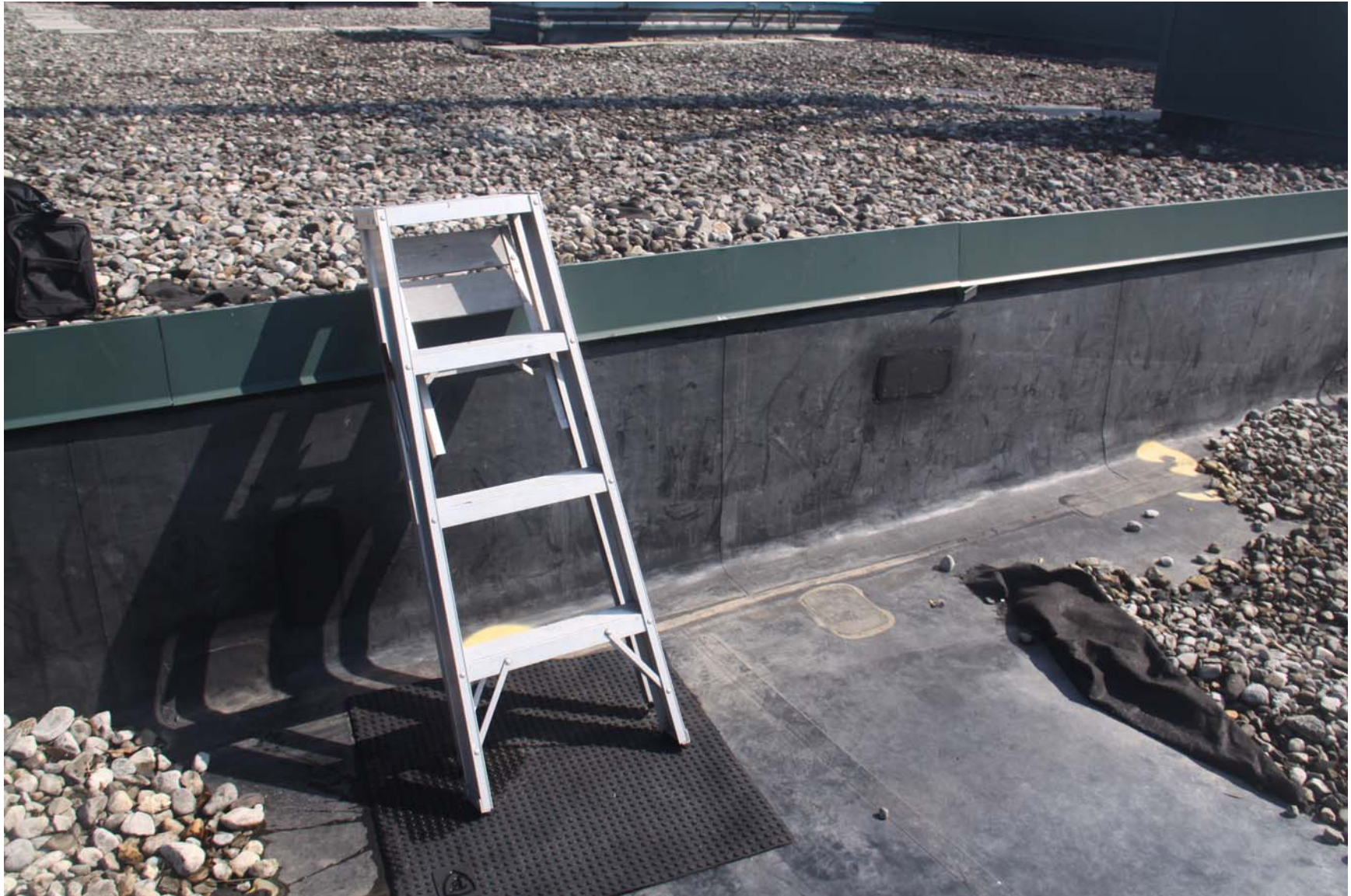
2219-00_19_0801 - ECs Roof [MP] (1052).JPG
