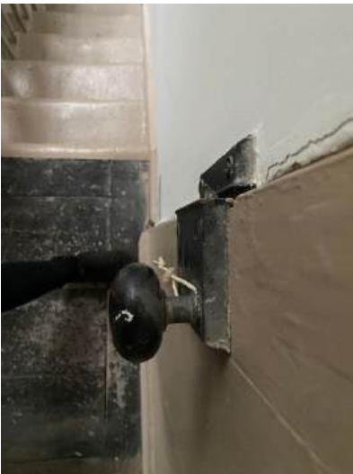
209.1 Stair hall side.JPEG
