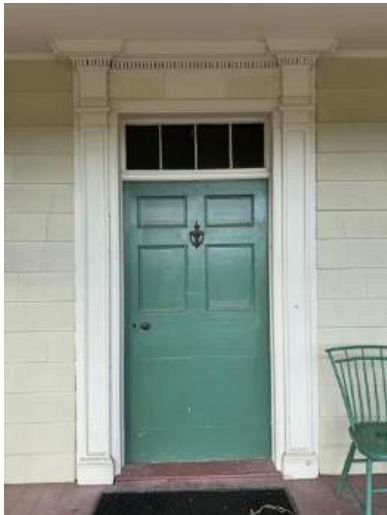
101 Front door Porch view.jpeg
