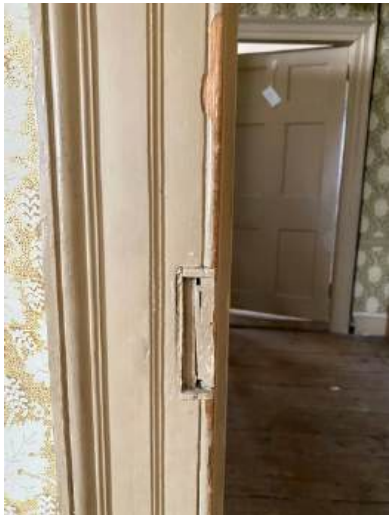
104 jamb room side.JPEG
