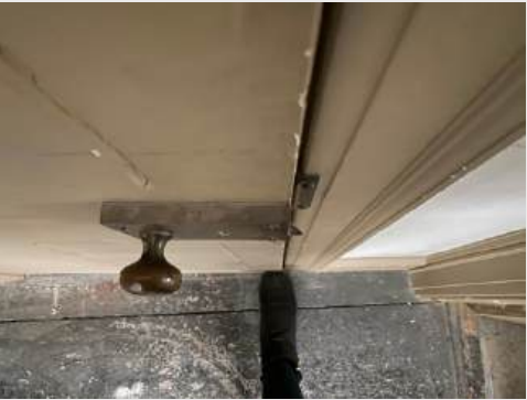
209.2 Stair hall side.JPEG
